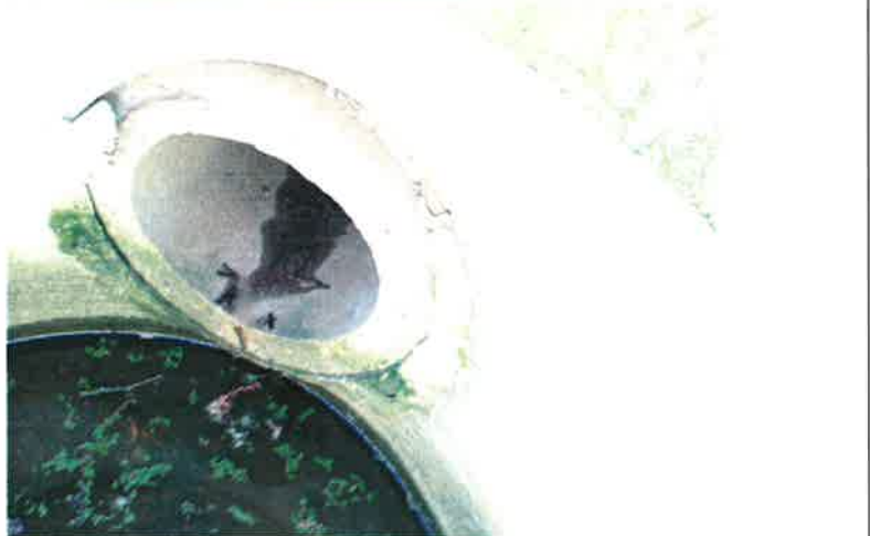
15" Riser Outlet Orifice
